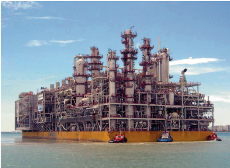
Abb. 7.10 Anlagen-Modul: LNG plant for Melkoya on a barge. (Bild: Linde AG)
