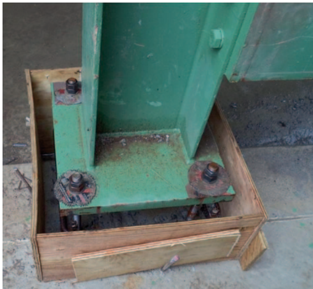
Abb. 3.16 Stahlbau – Unterlegscheiben. (Bild: Stefan Boos)
