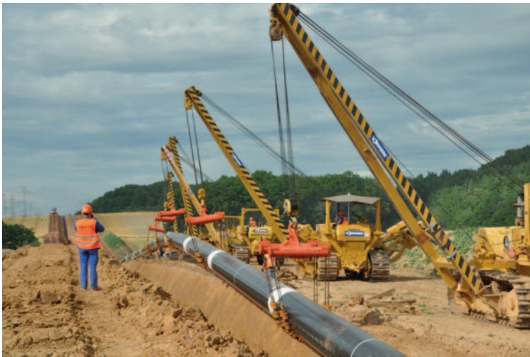
Abb. 2.7 Verlegung einer Erdgas-Pipeline. (Bild: GASCADE)
