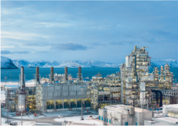
Abb. 7.3 Baustelle unter winterlichen Bedingungen – LNG Plant. (Bild: Linde AG)
