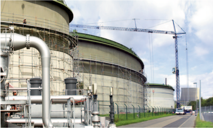
Abb. 4.3 Liebherr MK 88 im Einsatz. (Bild: Fa. Liebherr)
