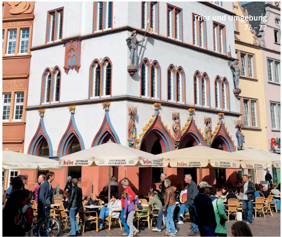
Eines der bedeutendsten Gebäude am Hauptmarkt ist die „Steipe“ mit ihren charakteristischen Stützbögen. 1483 erbaut, im Zweiten Weltkrieg zerstört und 1970 wieder aufgebaut.
