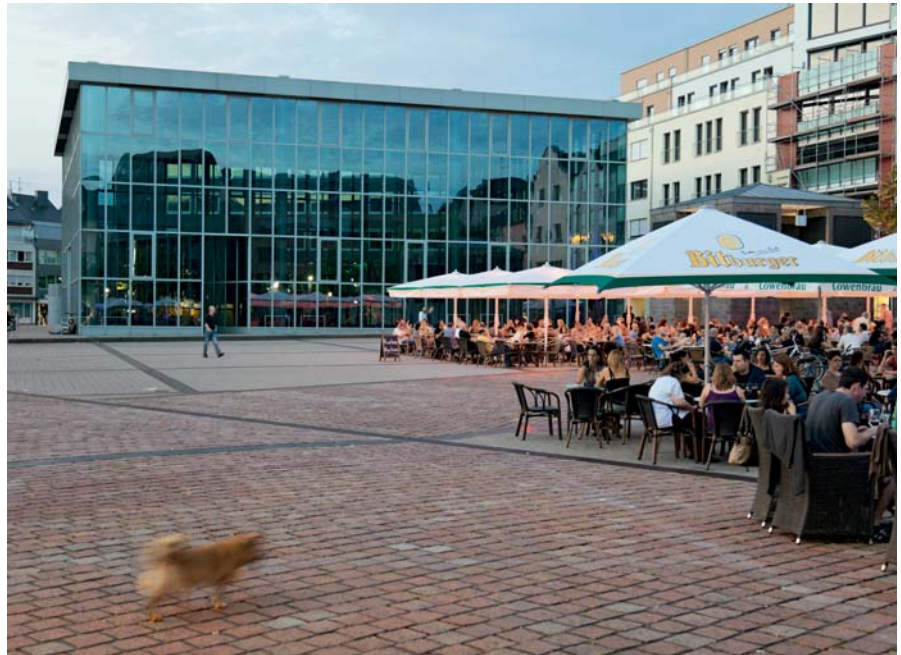
Am Viehmarkt schützt ein imposanter Glasbau die Reste der römischen Therme.
